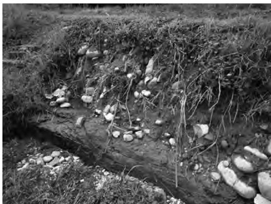
図 6. 参道の崩落により露出した岩盤
